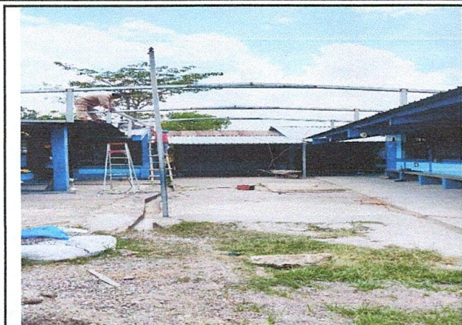
Foto 1: MEJORAMIENTO DE ESTRUCTURA TECHO PORTICO
